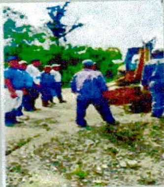
Trabajos con la maquinaria
