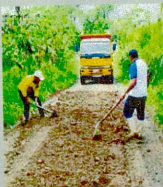
Lastrado de la vía
